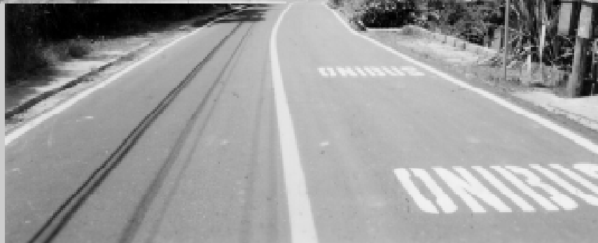
Recapeamento da Av. Francisco Torres na Candelária
